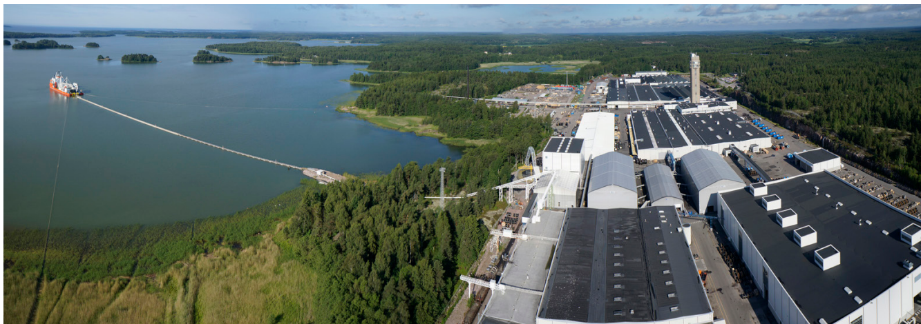
Prysmian Group on investoinut Pikkalan kaapelitehtaaseen viime vuosien aikana noin 100 miljoonaa euroa. Tehtaan ilmakuvasa lastataan merikaapelia kaapelinlaskualukseen.
