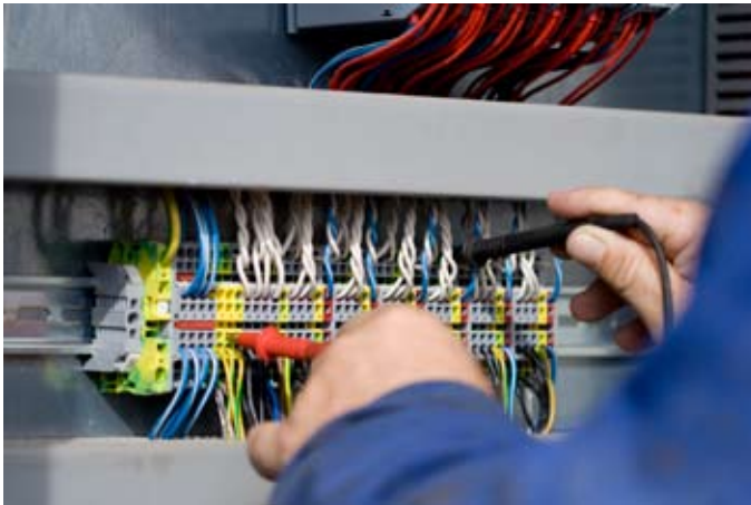
Sähköasentaja mittaa jännitettä riviliittimistä.
