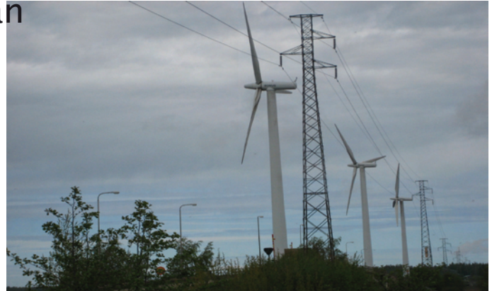
Meri-Porissa sijaitsee yksi maamme suurimmista tuulipuistoista. Tuulipuisto koostuu kahdeksasta 1 MW:n ja yhdestä 2 MW:n voimalasta.
